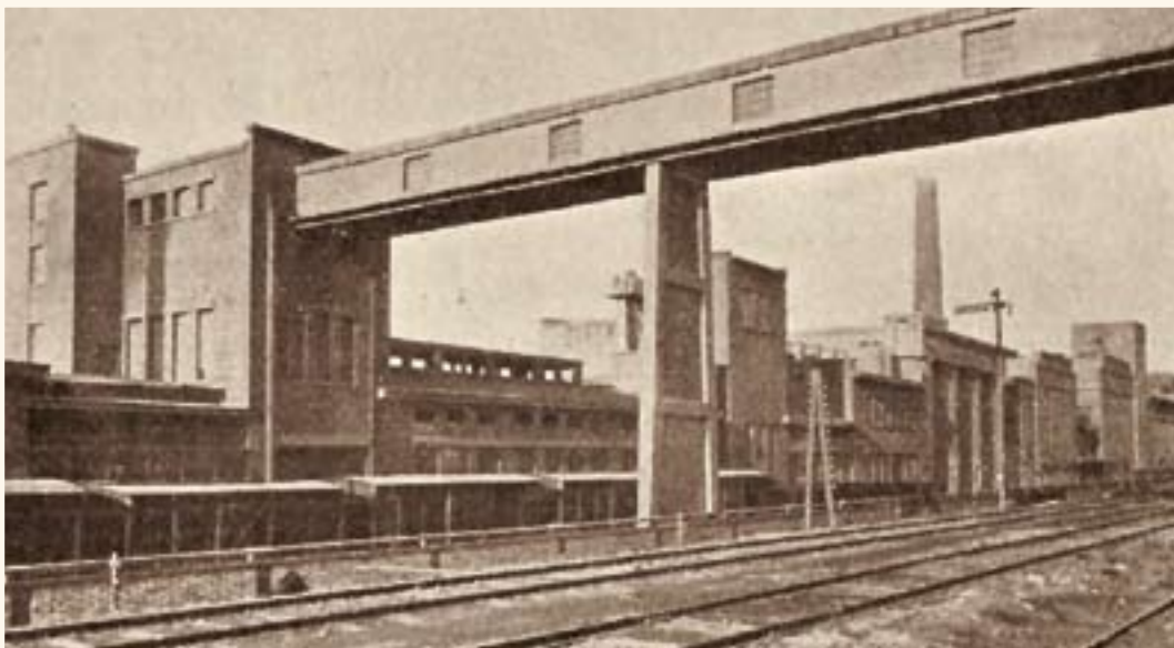
Dopravní můstek vedoucí přes železniční trať Praha–Plzeň
