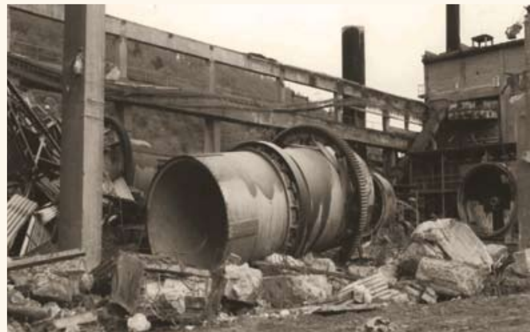
Demolice Závodu III
