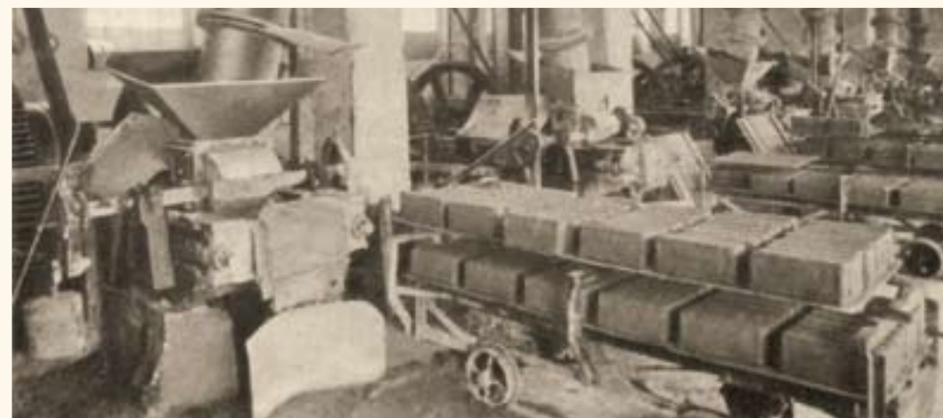
Pohled do budovy struskové cihelny na lisy
