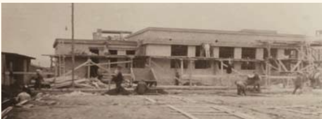
Z výstavby skladů a mechanických dílen Závodu I
