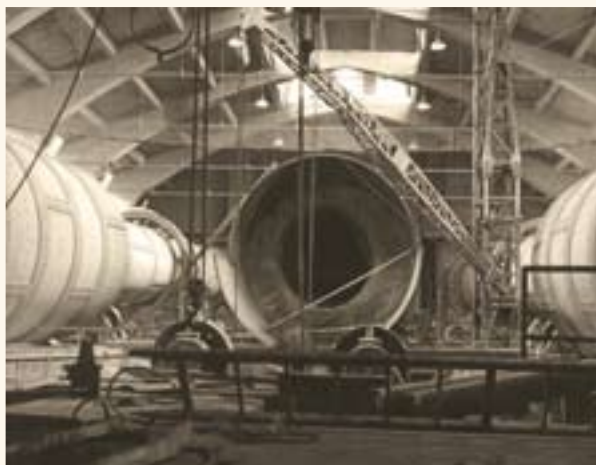
Rekonstrukce rotačních pecí na Závodě I na počátku 60. let
