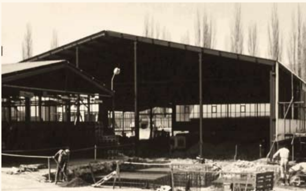
Stavba paletizační linky
