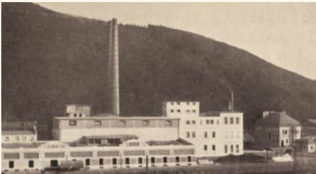
Pohled na západní část továrny s výpravnou a silem na portlandský cement, 1911
