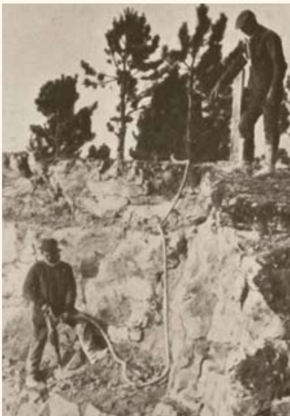
Vrtání v lomu pomocí pneumatického zařízení, kolem 1911
