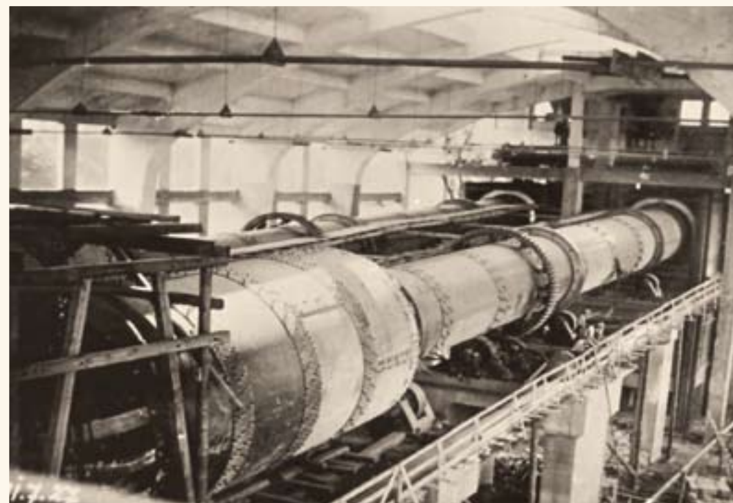
Instalace rotačních pecí
