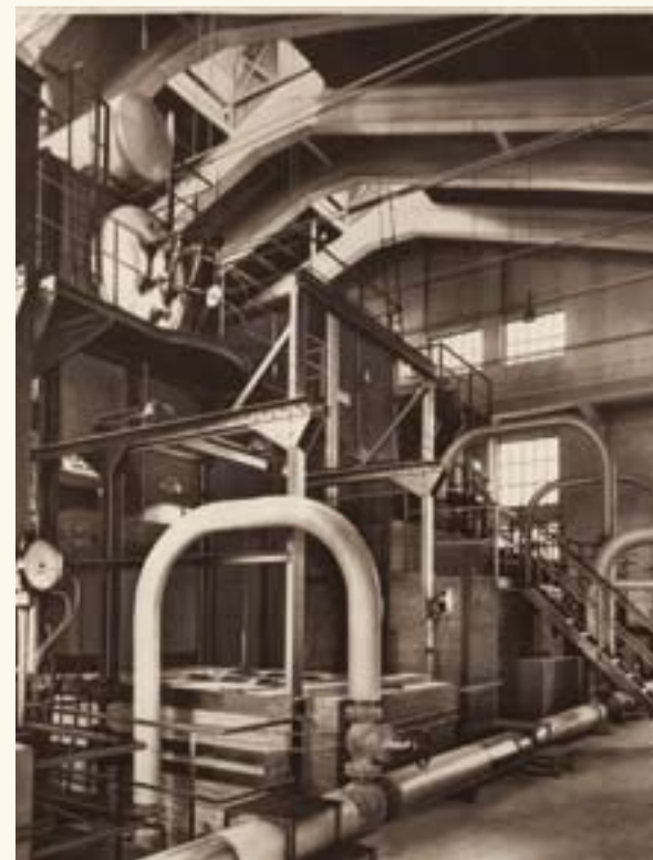
Kotelna Závodu II
