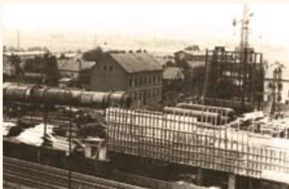
Postup výstavby rotačních pecí na Závodě III
