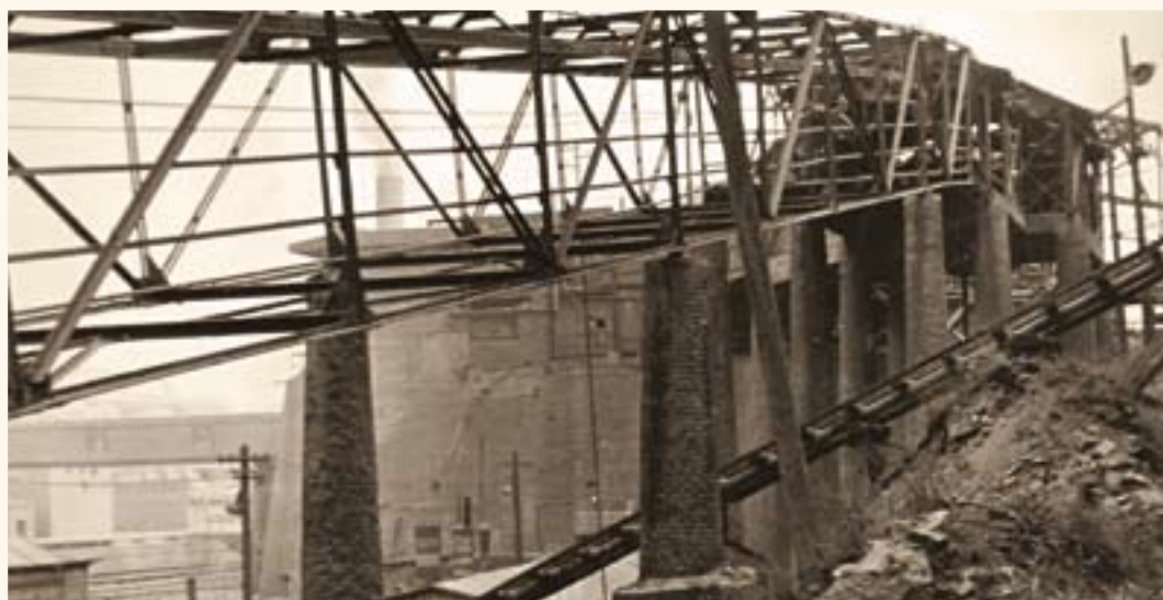
Lanová dráha k vápenným pecím Závodu II před demolicí
