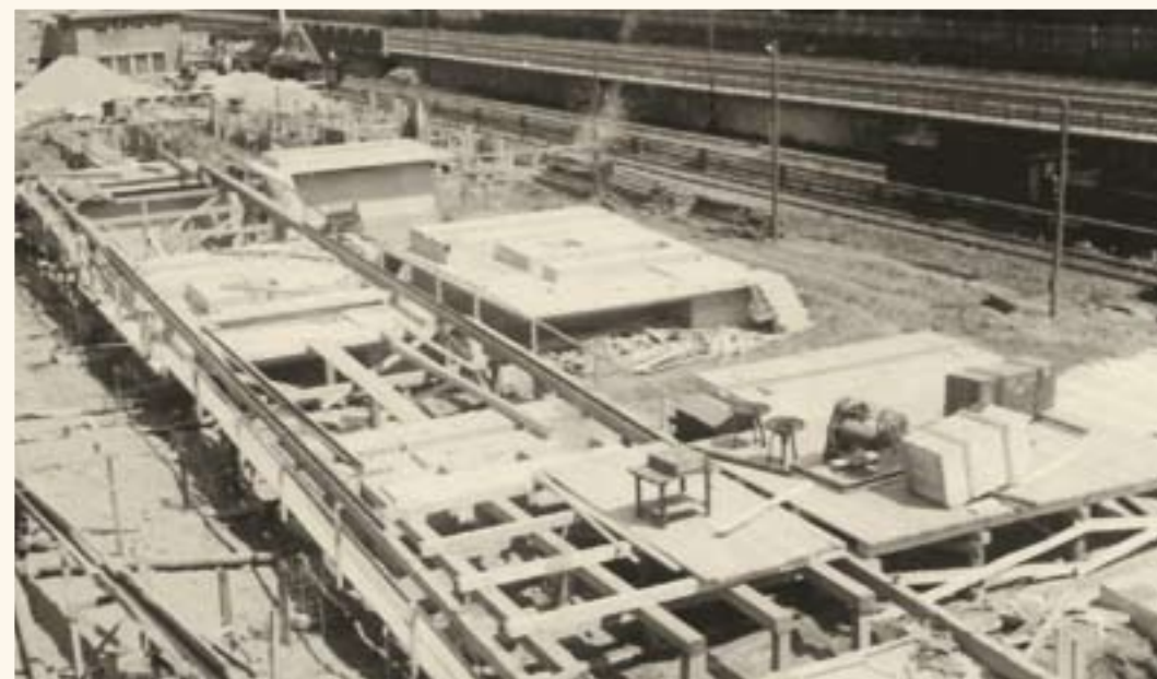
Postup výstavby rotačních pecí na Závodě III
