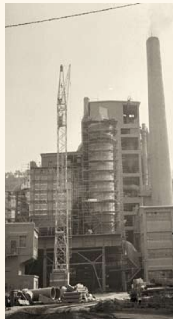
Výstavba elektroodlučovačů za rotačními pecemi č. 2, č. 3, 1973–1974
