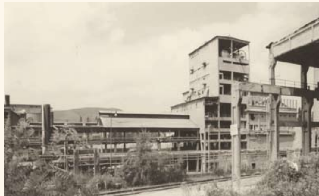
Budova rotačních pecí Závodu III
