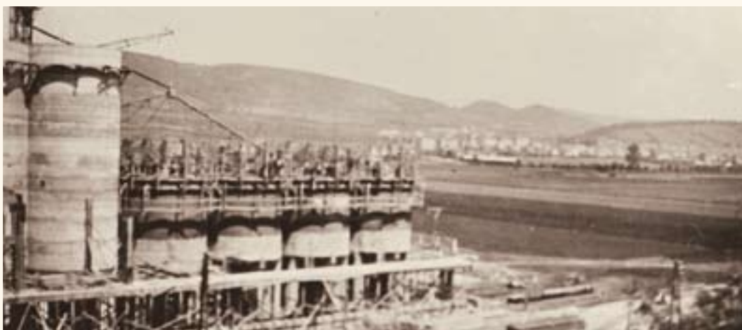
Výstavba cementových sil s posuvným bedněním
