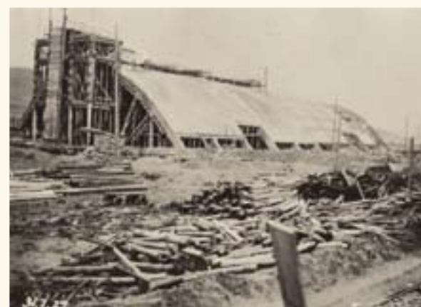
Snímky ze stavby skladiště slínku dokumentují i rychlé tempo výstavby. První pochází z 5., druhý ze 17., třetí z 31. července 1927
