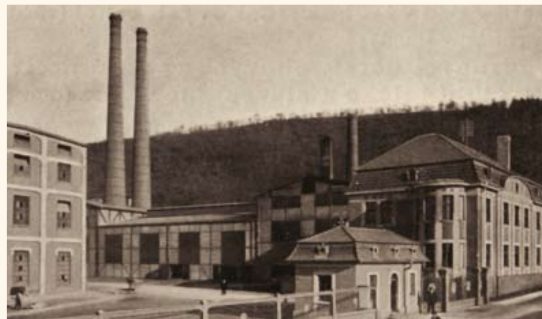
Administrativní budovy Královovské cementárny, 1911
