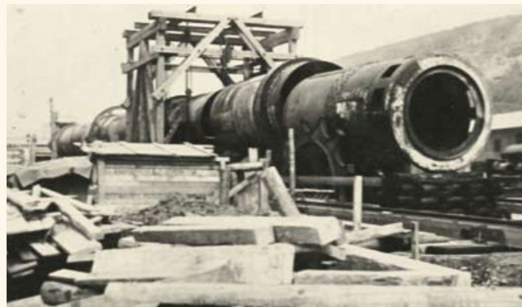
Postup výstavby rotačních pecí na Závodě III
