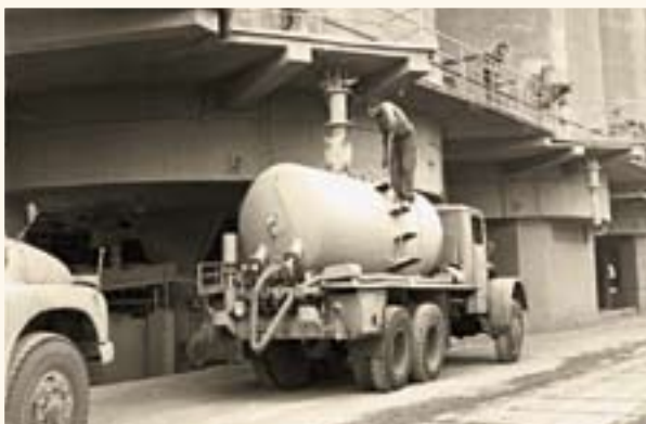
Expedice volně loženého cementu ze sil Závodu III do autocisteren
