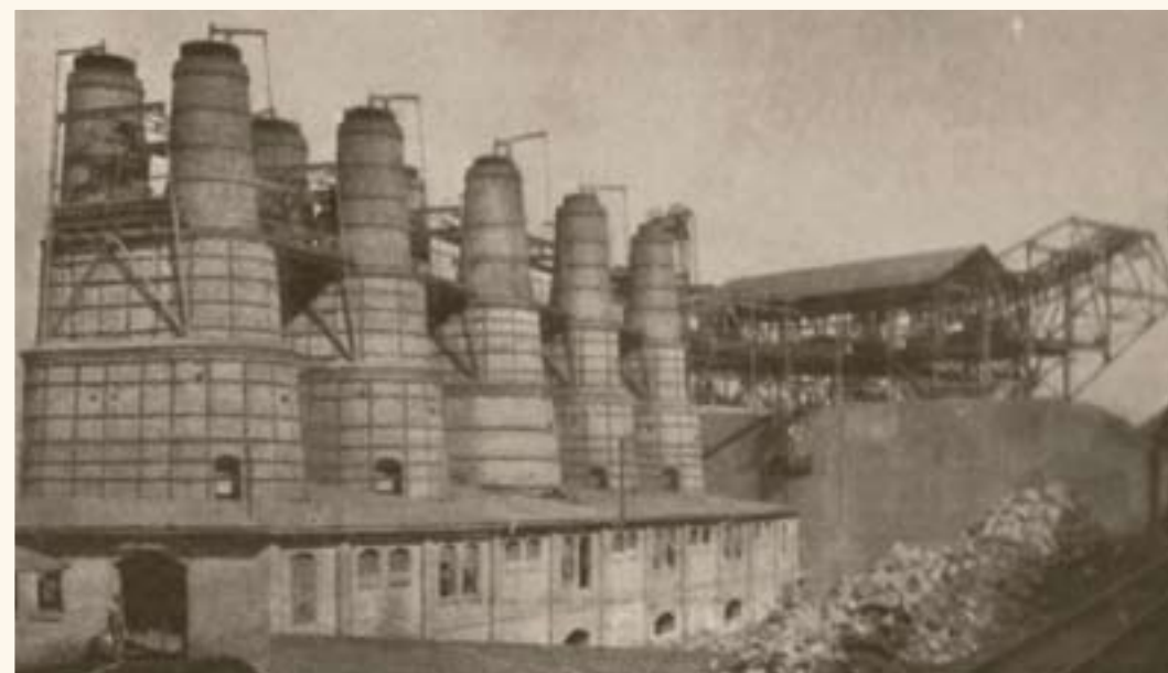
Pět párů šachtových pecí, tzv. pacoldovek, 1911
