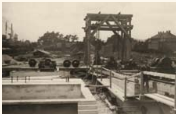
Postup výstavby rotačních pecí na Závodě III
