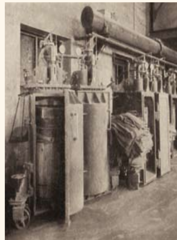
Pneumatický stroj soustavy Exilor na balení cementu, 1911
