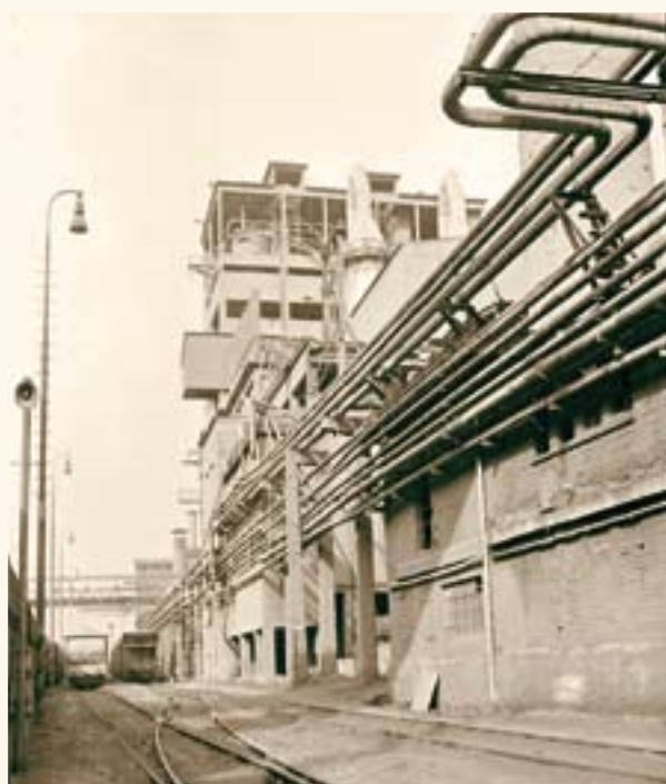
Vlečkoviště Závodu III
