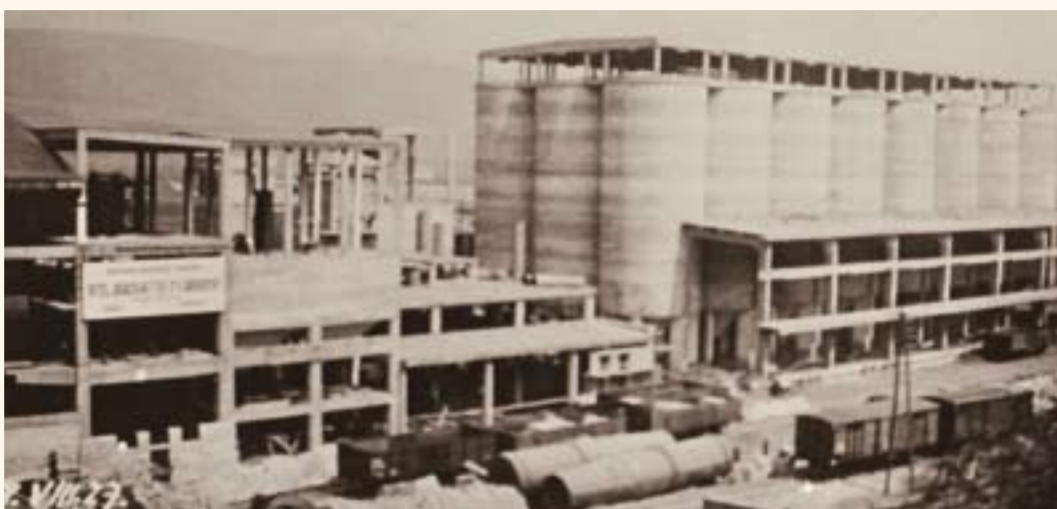
Z výstavby rotačních pecí
