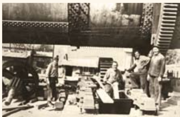
Postup výstavby rotačních pecí na Závodě III
