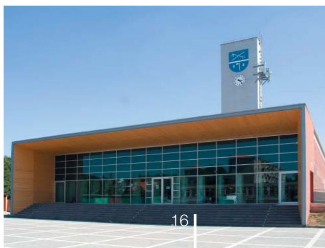
MOKRÁ: PŘESTAVBA BÝVALÉ UHELNÉ KOTELNY NA KNIHOVNU A SPOLEČENSKÉ CENTRUM
