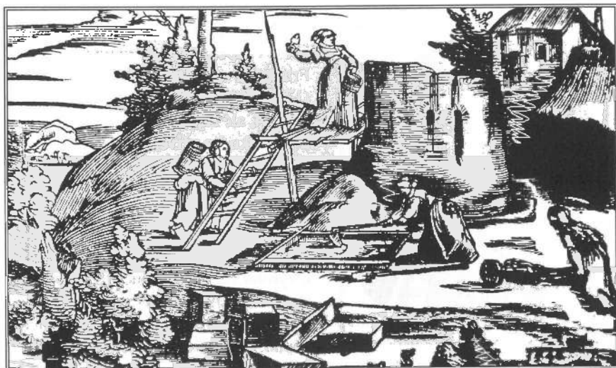
Václav Hájek z Libočan, Kronika česká, Praha 1541, dřevoryt zachycující manipulaci s vápnem při stavebních pracech, list 29.
