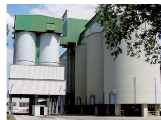
Dispatching terminal for VLC in Králův Dvůr
