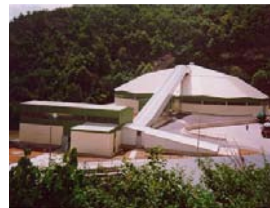
Předhomogenizační skládka
