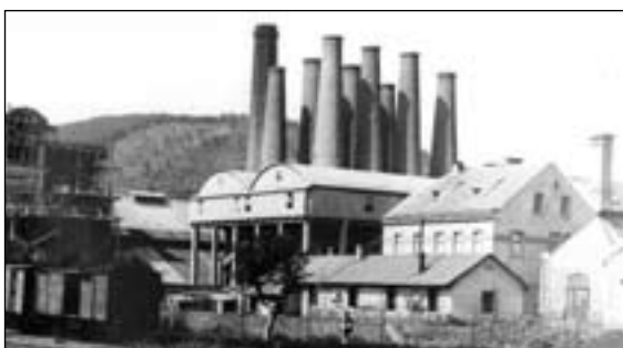
Detail staré cementárny Radotín z kolejiště
