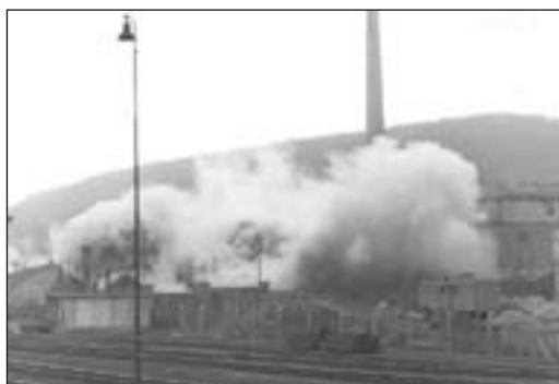
Demolice staré cementárny
