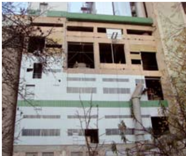
Opláštěním surovinové mlýnice došlo k výraznému snížení hlučnosti
