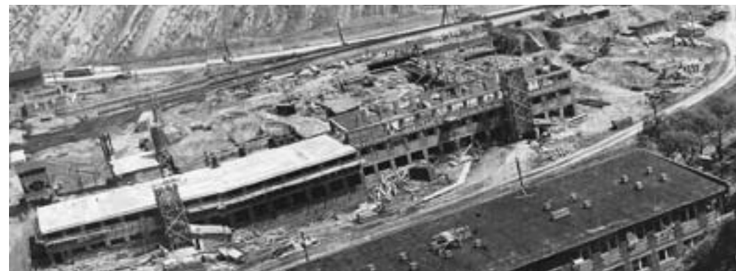
Výstavba nové cementárny – sociální zařízení, dílny a v popředí budova AB
