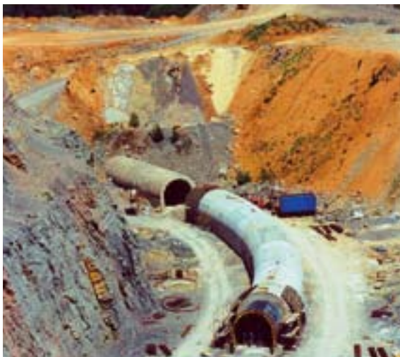
Výstavba tunelu do lomu Hvidálka
