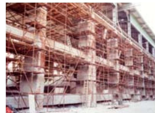
Skládka surovin v průběhu rekonstrukce
