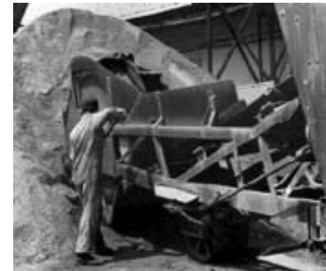
Struskový dopravník ve staré cementárně
