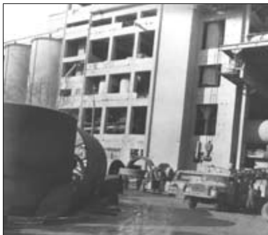
Oprava pláště rotační pece
