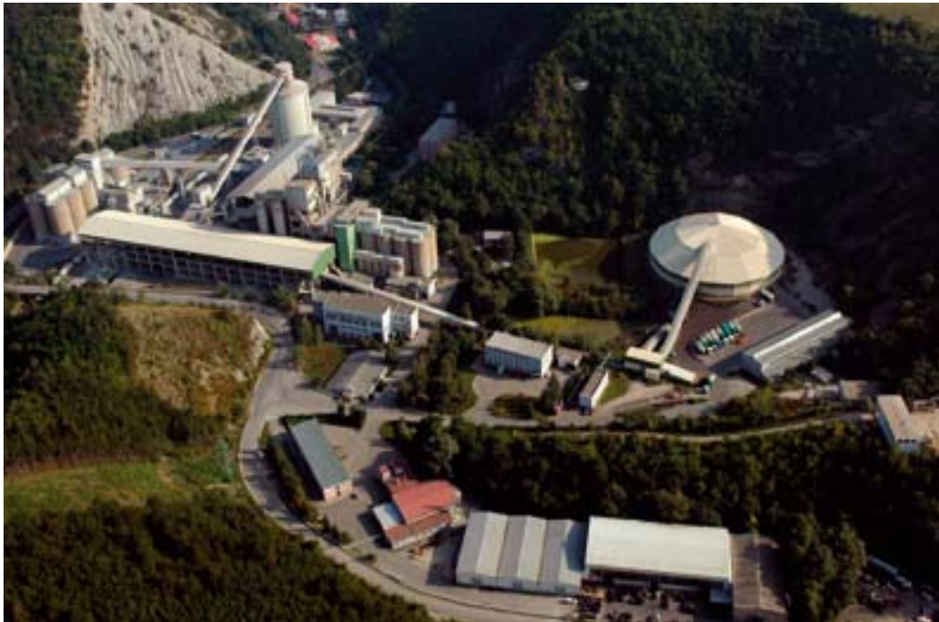
Letecký snímek – drtírna, PHS, závod, Pragoelast
