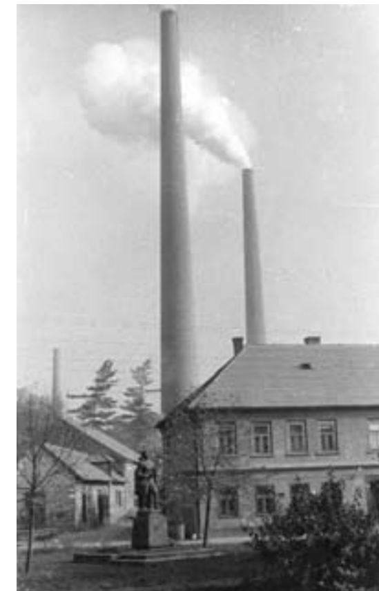
Stará cementárna v plném provozu
