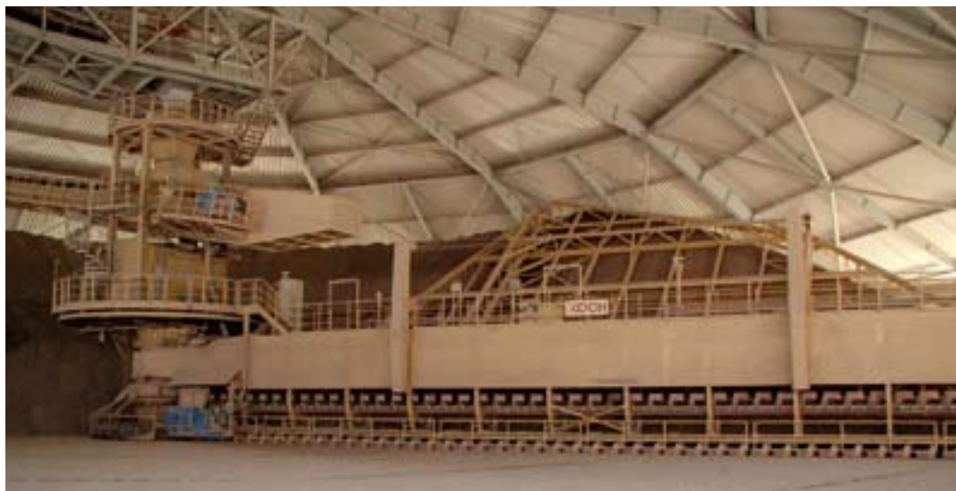
Předhomogenizační skládka (PHS)
