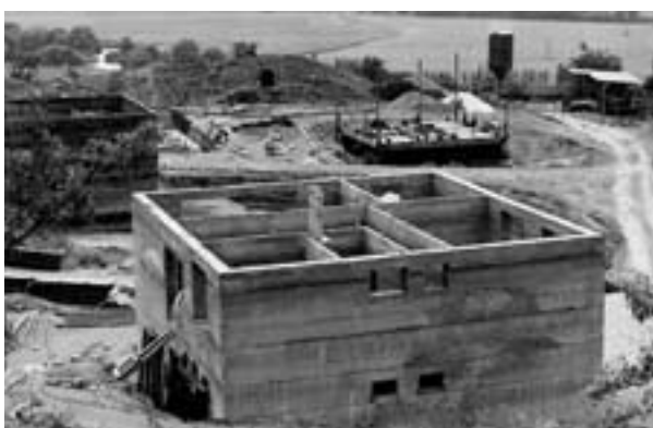
Díky posuvnému bednění postupovala výstavba velmi rychle
