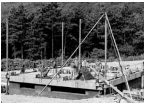
Při výstavbě bylo využíváno posuvné ocelové bednění
