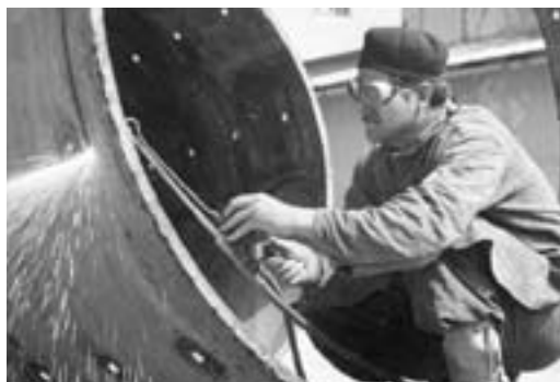
Likvidace surovinového mlýna ve staré cementárně
