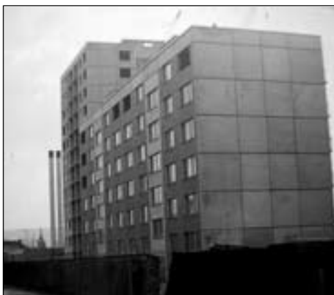
Za plotem staré cementárny nové sídliště Berounka
