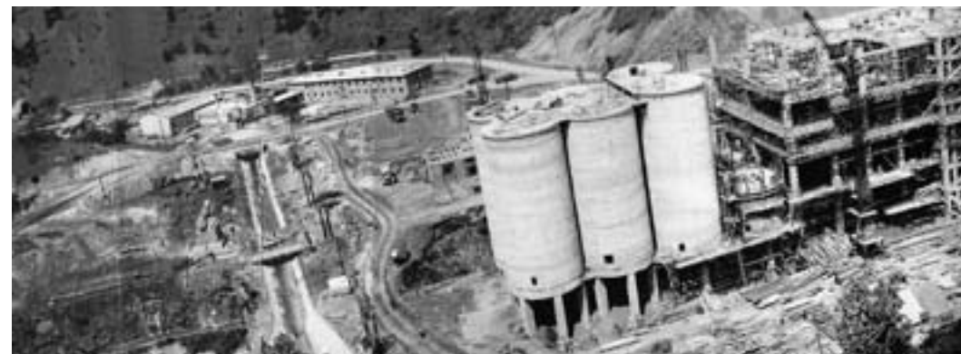
Výstavba nové cementárny – surovinová sila
