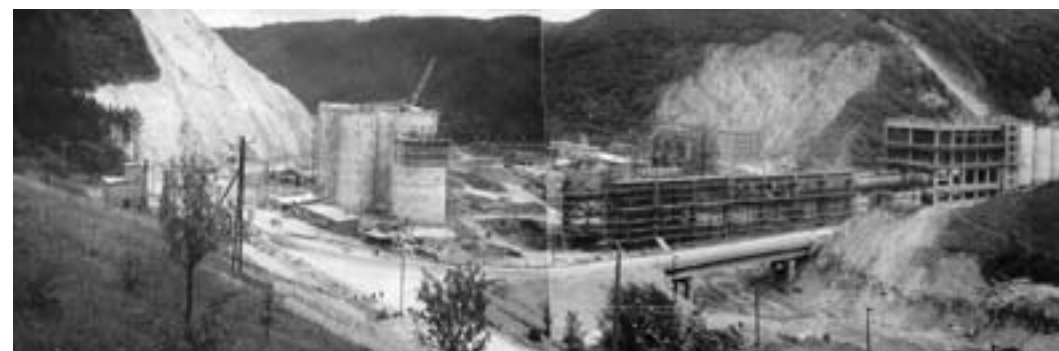
Celkový pohled na výstavbu nové cementárny
