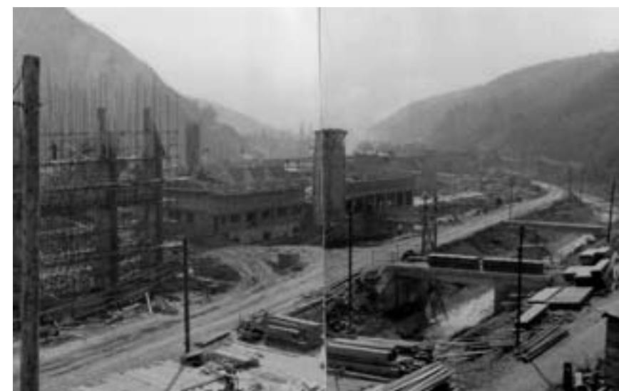
Staveniště nové cementárny
