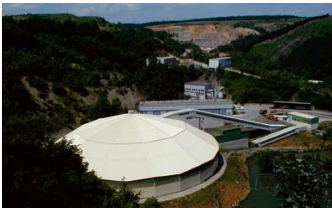
PHS od vodárny k lomům
