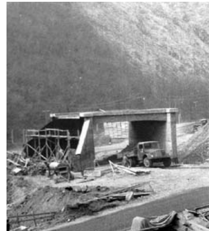
Výstavba podjezdu železniční vlečky – vjezd do závodu
