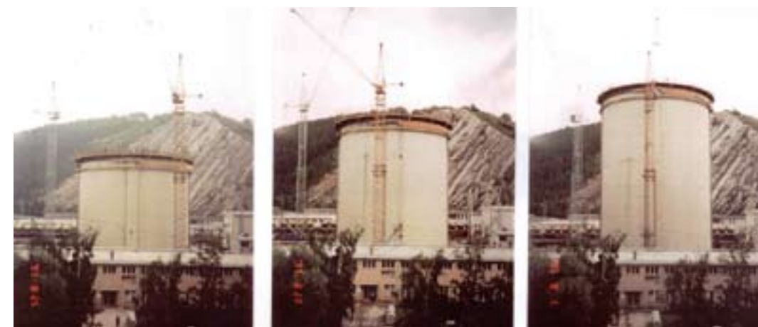
Výstavba slínkového sila – fotografováno v týdenních intervalech
