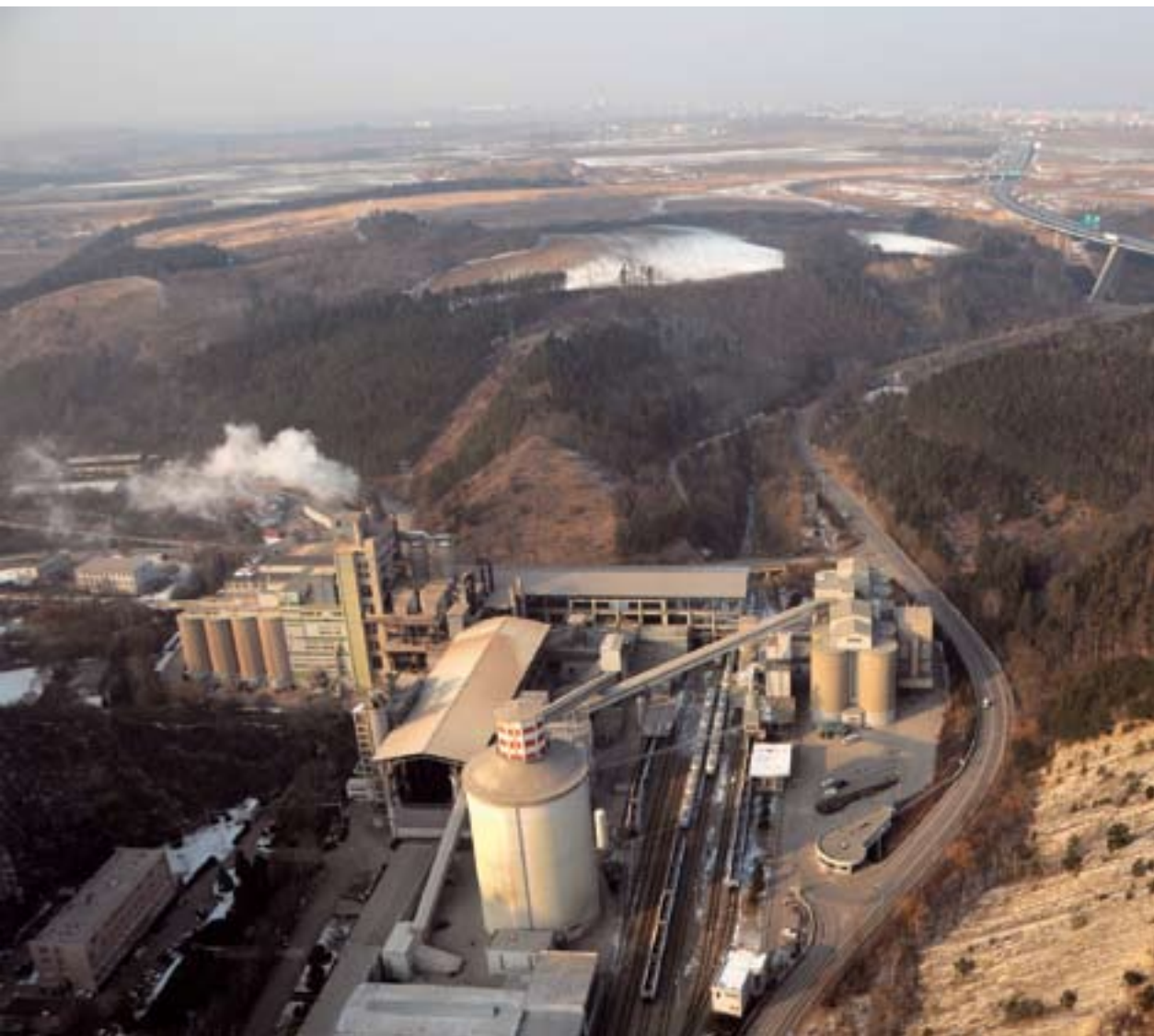
Pohled z balonu 2011 – cementárna Radotín, v pozadí přemostění Lochkovského údolí
