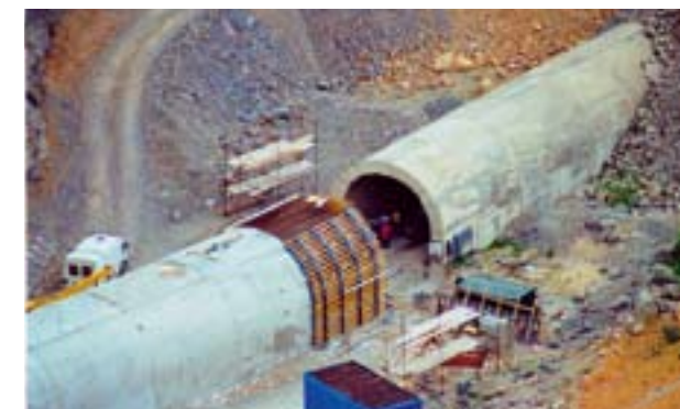
Prodloužení tunelu na 332 metrů
