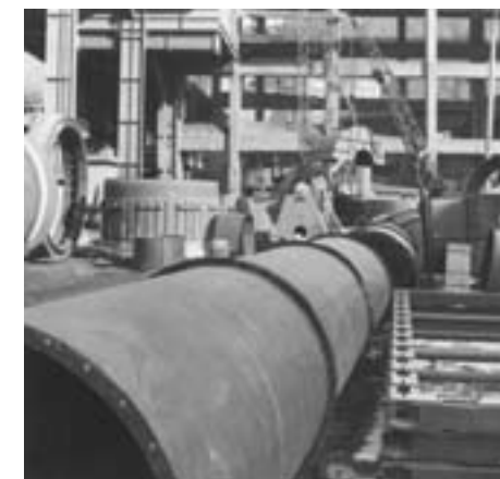
Oprava potrubí k elektrofiltrům
