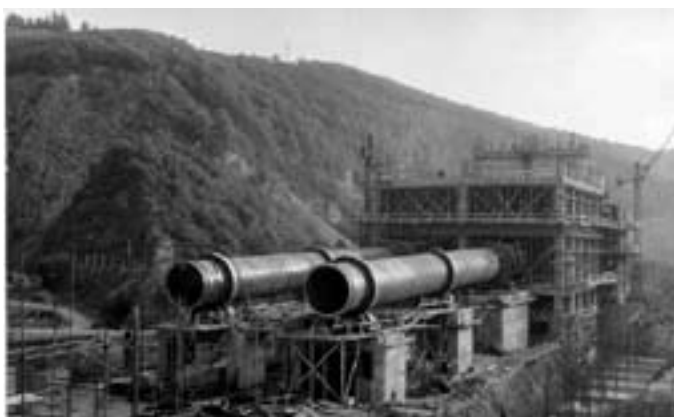
Výstavba nové cementárny – pece
