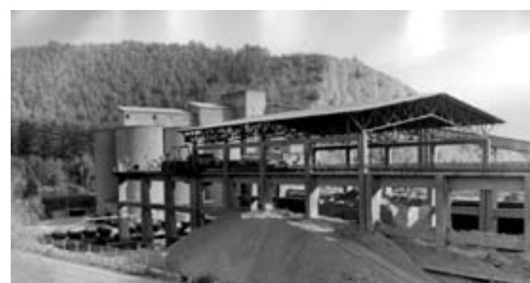
Zásoby strusky převyšují úložný prostor v jeřábové dráze
