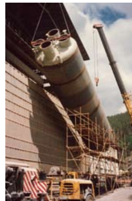
Výstavba uhelné mlýnice
