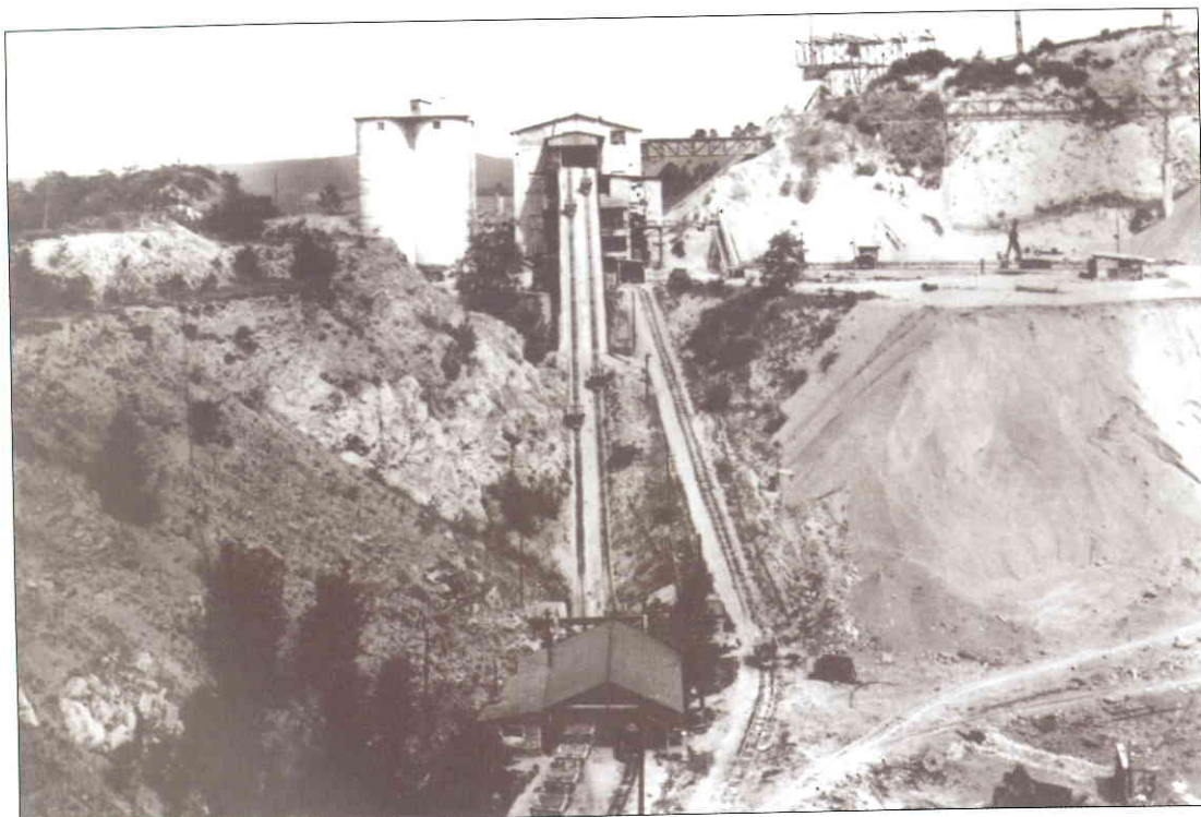
Ze dna starého lomu - šikmá řetězová dráha do zásobníků nad kladivovými drtiči
