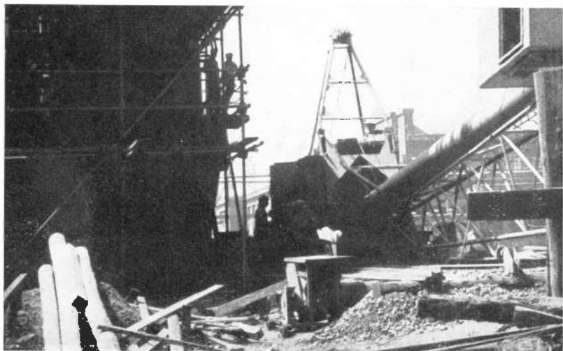
Detailní záběr z rekonstrukce podniku – r. 1960.
