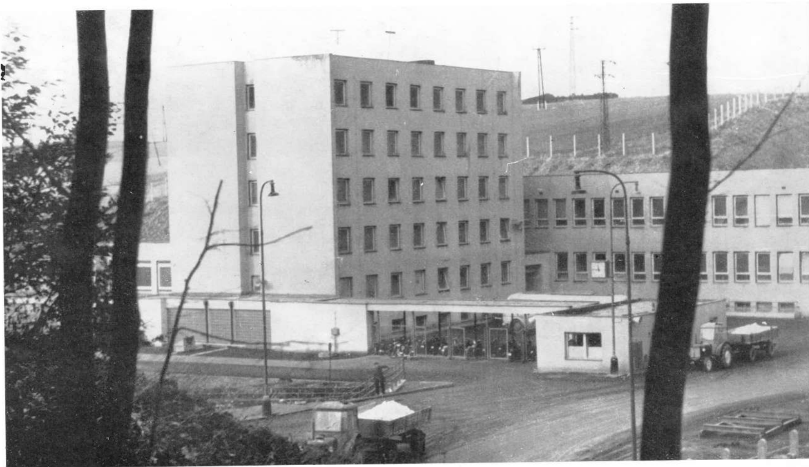
Administrativní budova na VČS.
