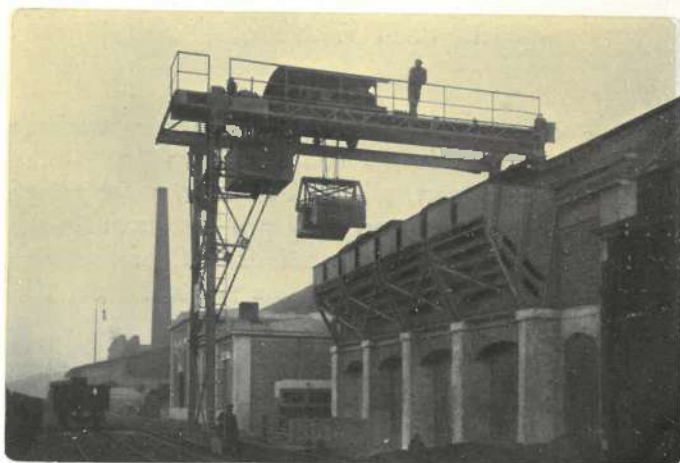
Průčelí strojovny při dráze s jeřábem a nádržemi na uhlí.
