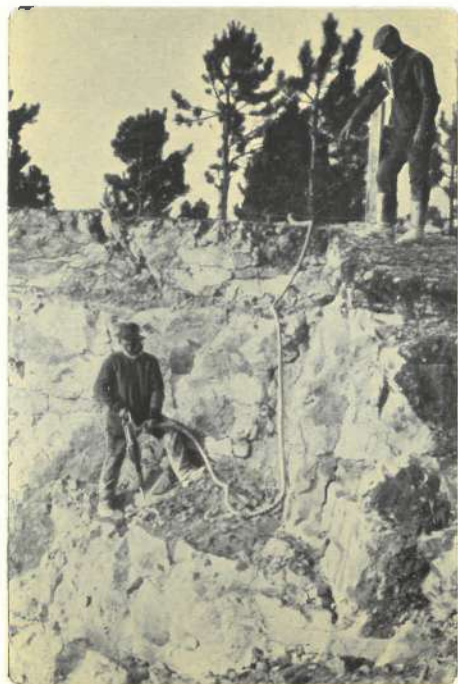
Vrtání děr pomocí pneumatických vrtacích přístrojů.
